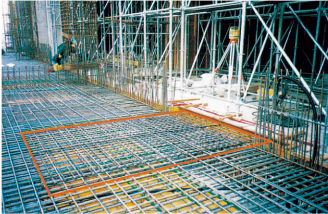
スラブコンクリート内に埋設
